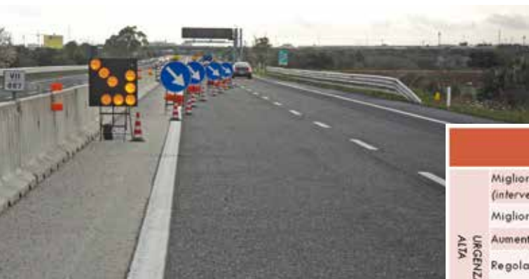
1. Segnaletica stradale da cantiere
