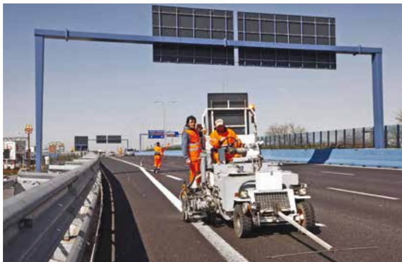
2. Una macchina operatrice impiegata per la realizzazione di segnaletica in termocolato plastico
