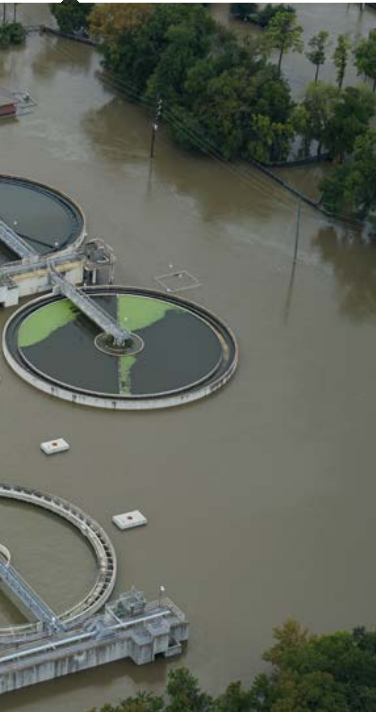
Impianto di trattamento delle acque reflue allagate dopo l'uragano Harvey (USA)
